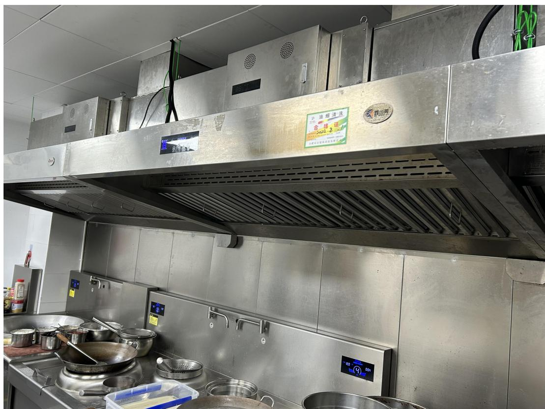
图 3-10 食堂油烟净化器设备照片
