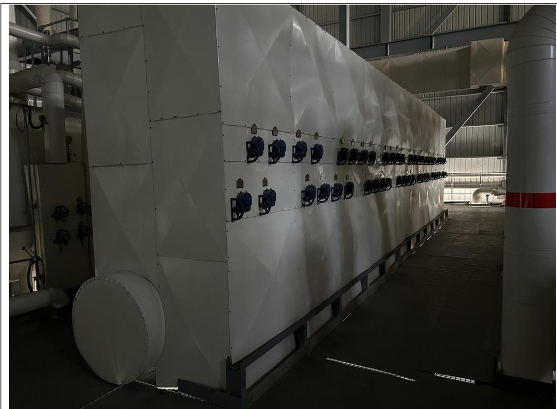
图 3-9 废气脱硝设施现场照片
