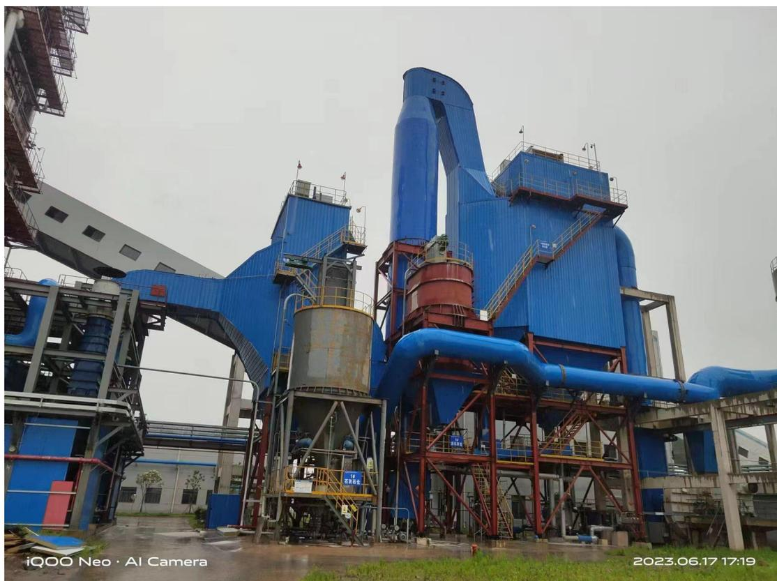
图 4.1-5 本项目脱硫脱硝现场照片
