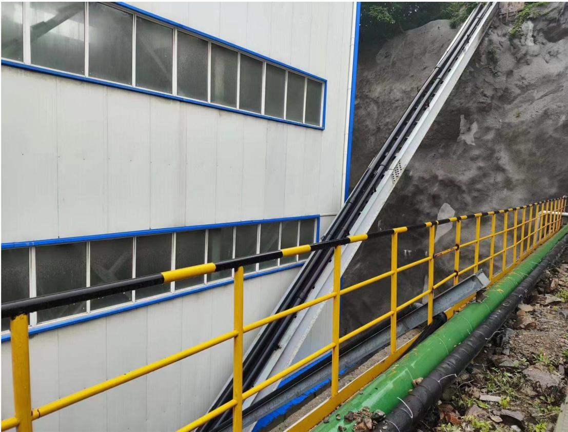
图 3-13 废水输送管道
