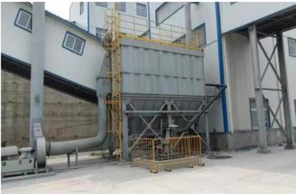
图 3-5 石子厂整形厂房废气处理
