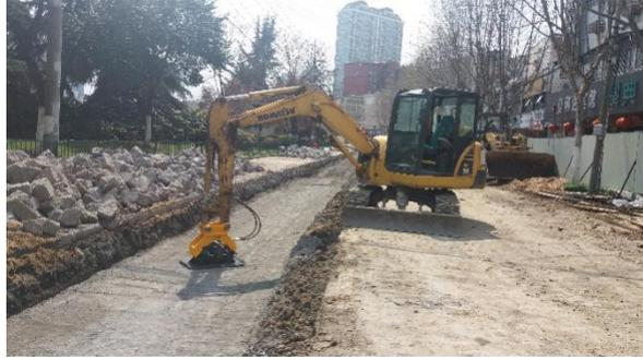
图 2 路面平整施工图
