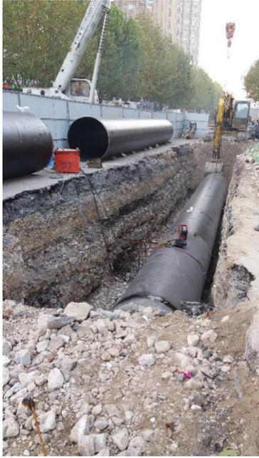
图 1 管道铺设施工图
